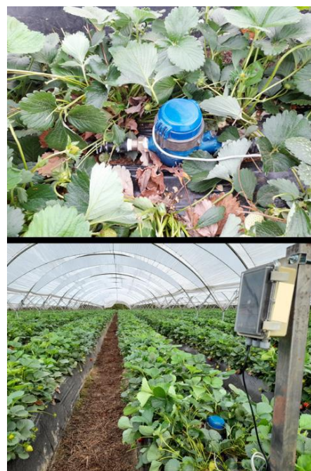
Figura 11. Estación remota para el control de parámetros de riego, instalado en cultivo de fresa.
