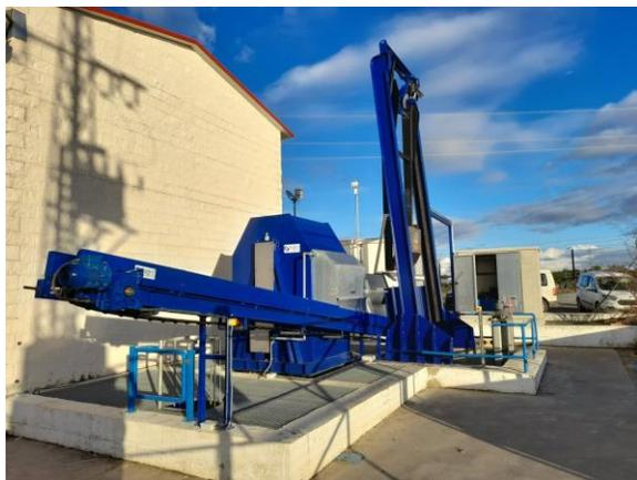
**Figura 6.** Sistema de filtrado Canal-1, ubicado en la captación del canal del Piedras (Cartaya).
