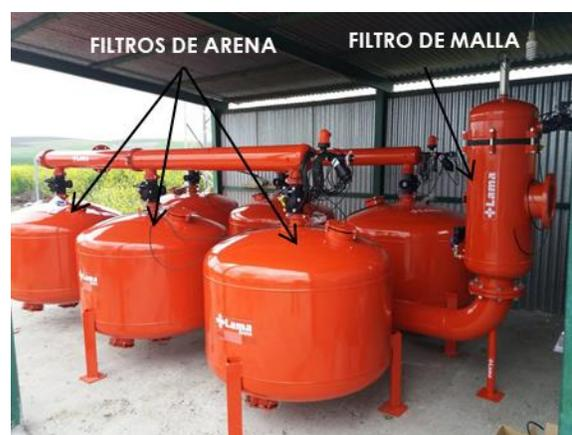
Figura 1. Equipo de filtrado de arena y malla.
